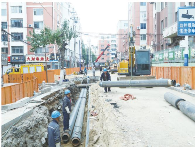
施工人员铺设对接全新的供热管道。
