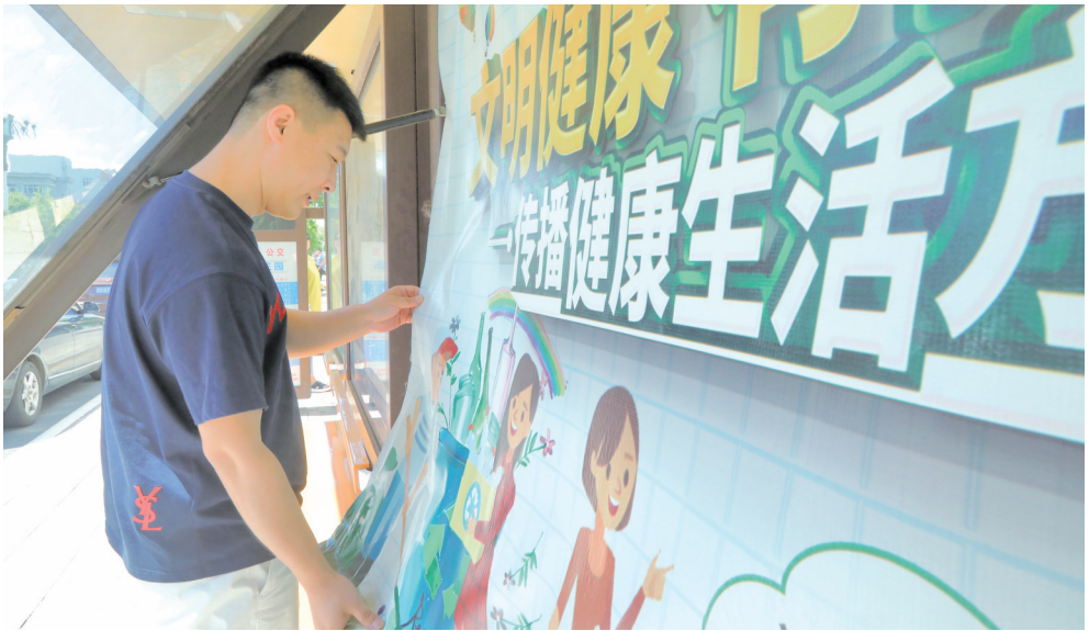
公交公司工作人员对站牌进行维修翻新。
