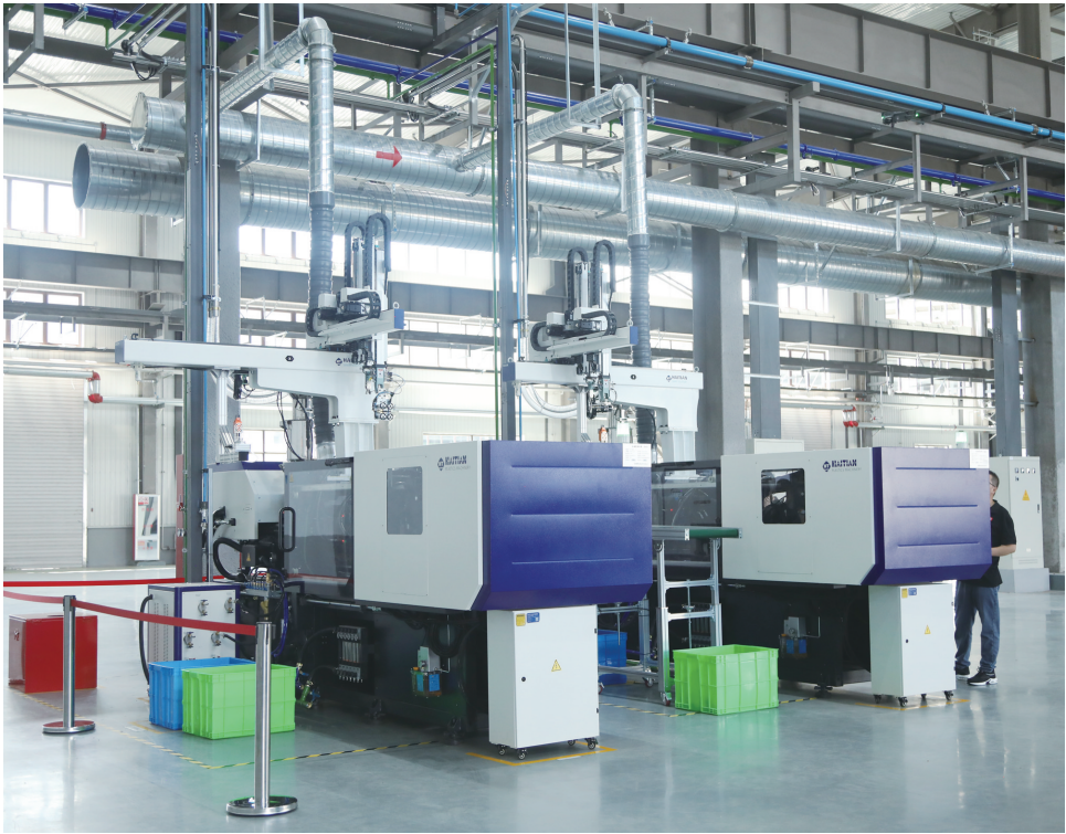
博戈辽源智造基地部分设备已进场并完成调试安装。
