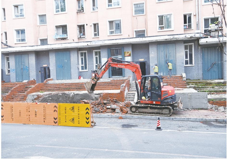
工人们在我的家园小区进行门房台阶修复工作。
