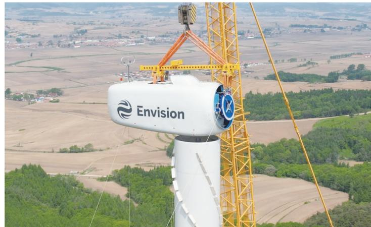
机舱与塔筒实现精确对接。
