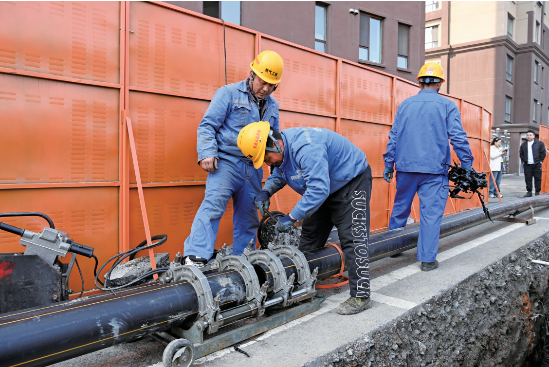
燃气改造施工现场。 本报记者 王彦雨 摄
