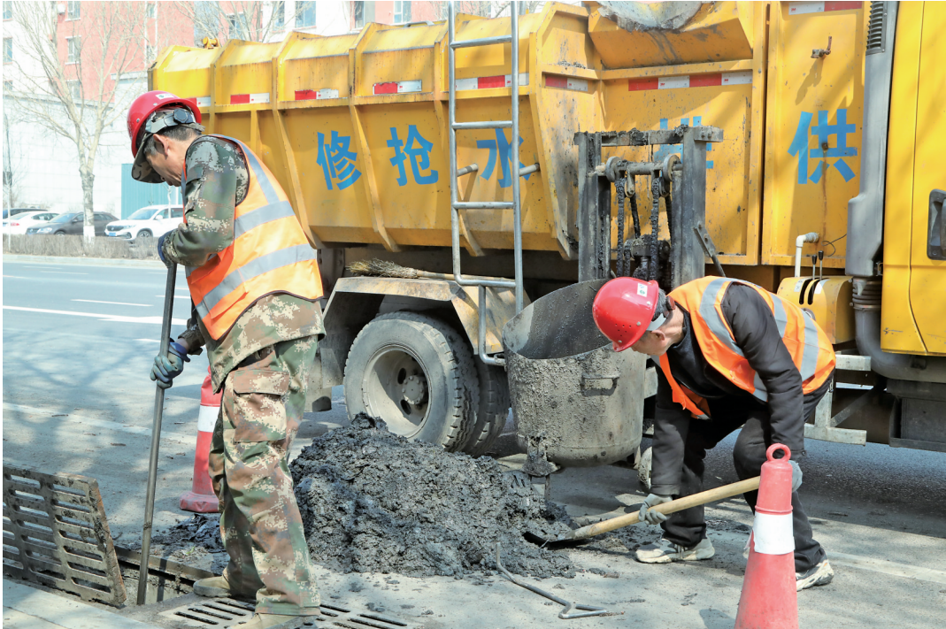
西宁大路排水设施清掏现场。
