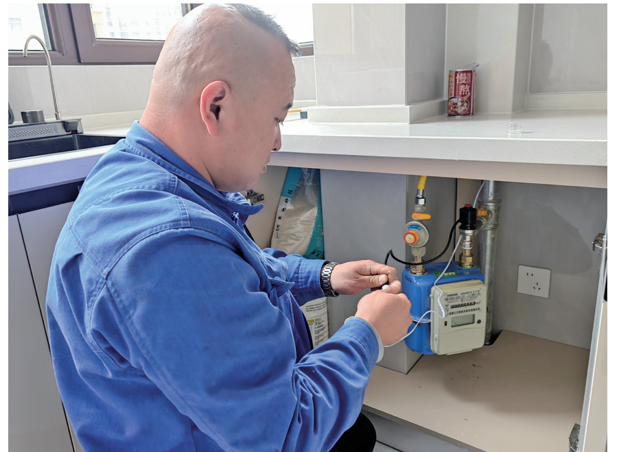
工作人员在为居民安装智能激光燃气报警器及自动切断阀。
