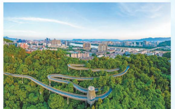
福建福州市在建设“福道”时,采取钢结构高架、镂空桥面栈道、节点大跨度桥梁等创新设计,最大限度保护森林原生态。
