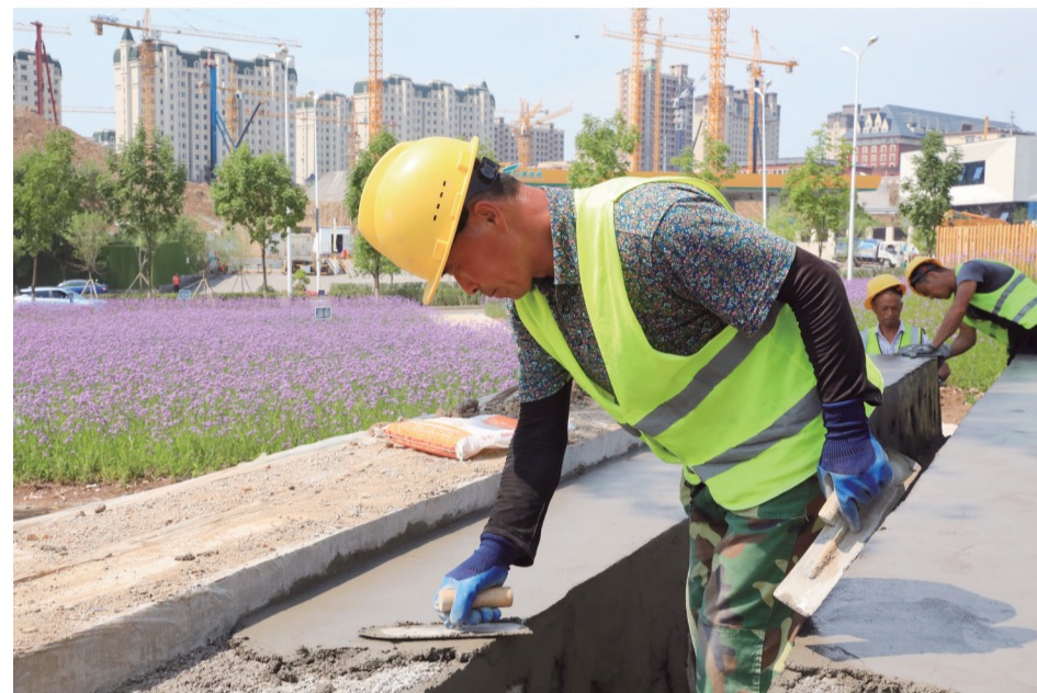
工人进行路堑边沟施工。
