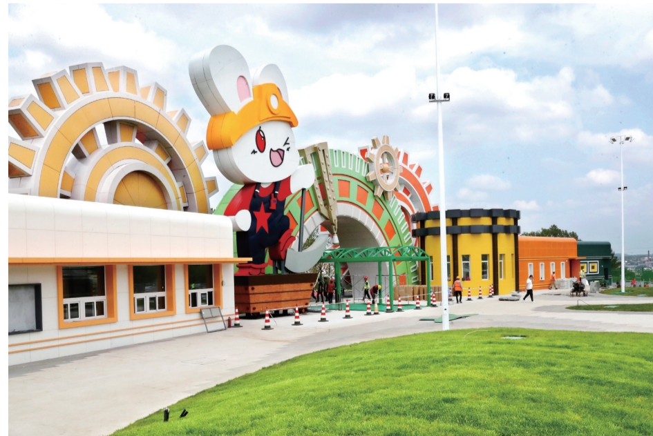
日前,由中庆集团投资建设的那兔乐园已经初具规模。彩虹滑道现已建成,旋转木马即将完成,两个大型无动力组团主体已完工。不久,那兔乐园就会与市民及广大游客见面。
