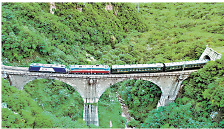
从四川省广元市开往陕西省宝鸡市的6064次慢火车,行驶在宝成铁路松树坡铁路桥上,旁边是郁郁葱葱的林海。 刘一江摄(人民视觉)
