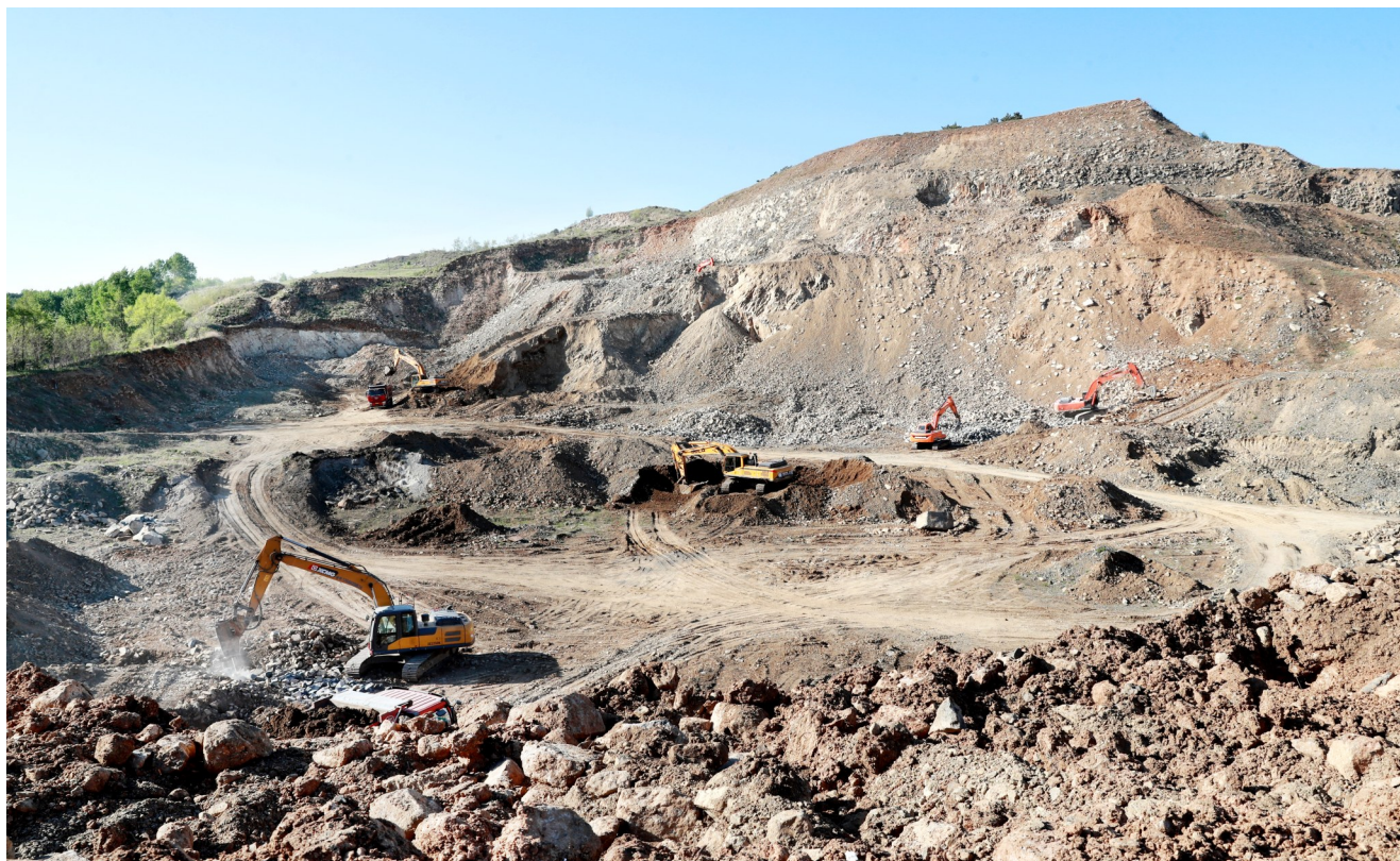
龙山区风电绿色修复风光储能氢氨一体化项目暨天祖老道山重力储能科普基地用地面积7.5万平方米,用于建设重力储能塔、能源展示馆等设施。该项目建成后,将促进辽源市绿色新能源产业链发展,构建新能源产业发展业态。因为项目所在老道山重力储能科普基地进行地质勘测和土地平整。
