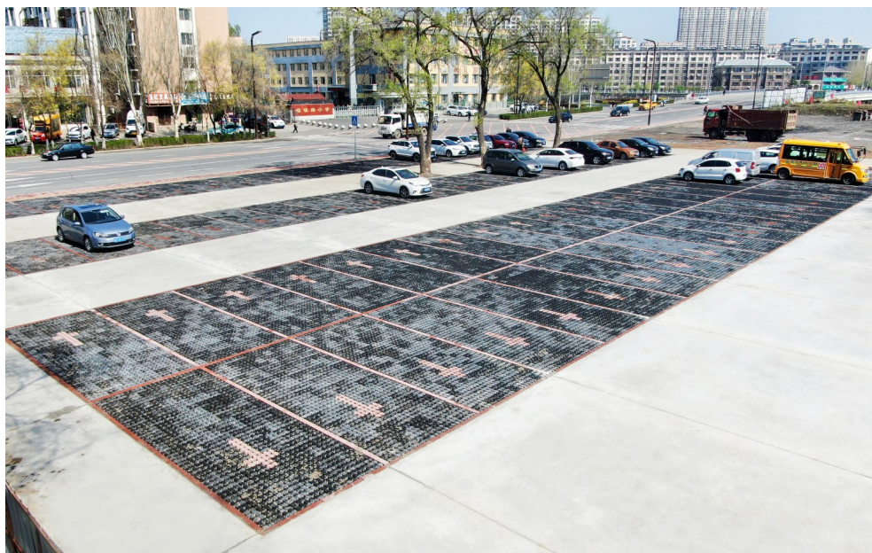
福镇路小学东侧新建停车场已建成并投入使用。
