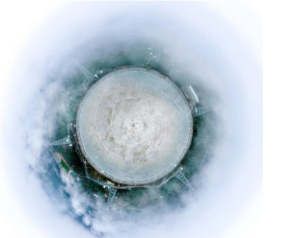
2月28日无人机拍摄的“中国天眼”(无人机全景图片,维护保养期间拍摄)。
