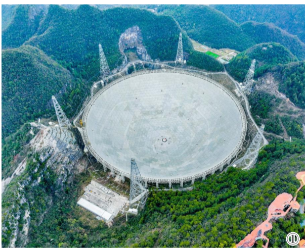
图①:2月26日拍摄的“中国天眼”(无人机照片,维护保养期间拍摄)。
