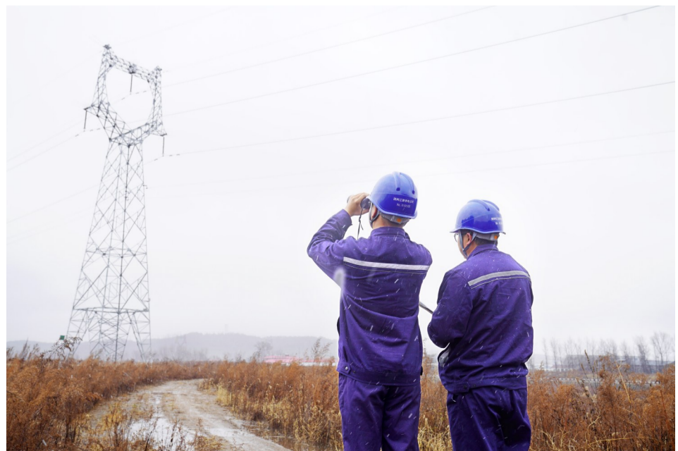
国网辽源供电公司工作人员顶风冒雪进行雨雪特巡工作。
