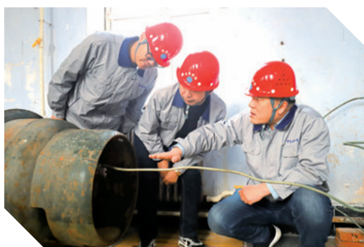
市水务集团净水厂技术人员在对设备进行日常检修维护。
