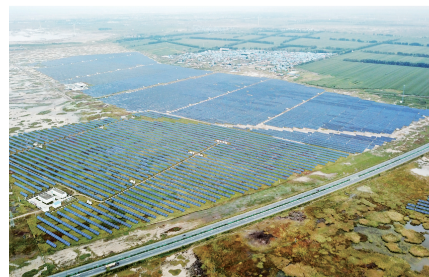
位于“石油之城”黑龙江省大庆市的一光伏发电项目基地。新华社记者 王建成 摄
