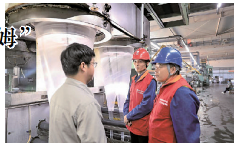
国网辽源市城郊供电公司工作人员主动深入吉林省华纺科技有限公司检查光伏发电设备,为企业提供用电服务。 赵姝丹 摄
