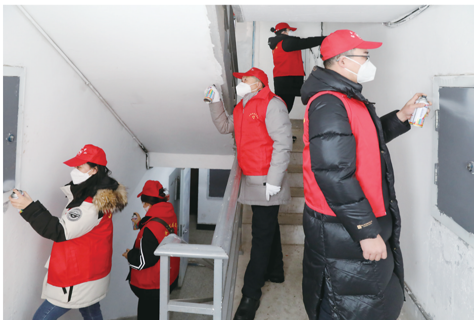
党员志愿者在阳光新城小区居民楼楼道内进行喷涂作业。
