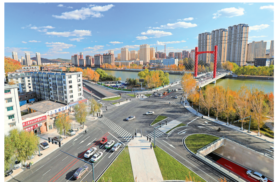
辽河大路与龙山大街交汇处新建的龙山隧道极大地改善了交通阻塞状况。
