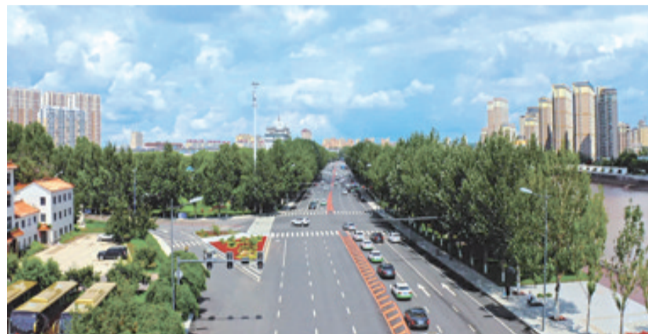
拓宽改造后的辽河大路缓解了交通压力。
