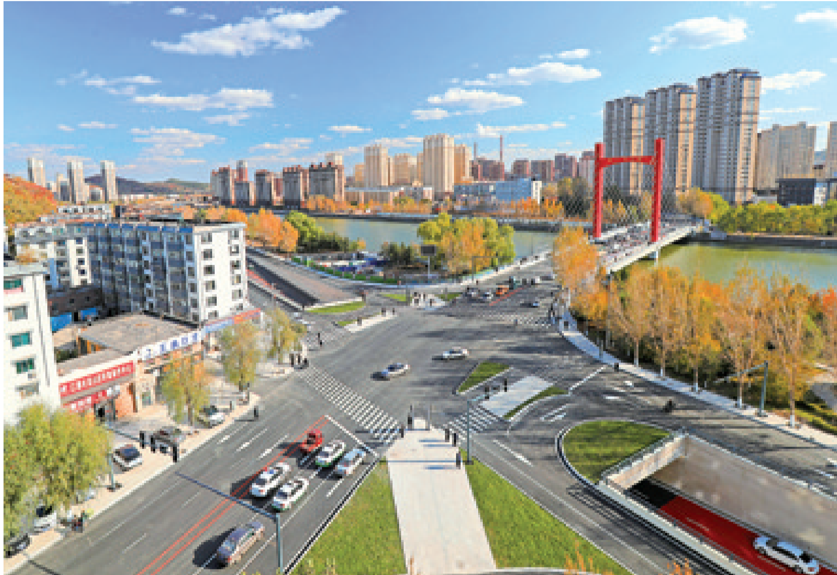
辽河大路与龙山大街交汇处新建的龙山隧道极大地改善了交通阻塞状况。
