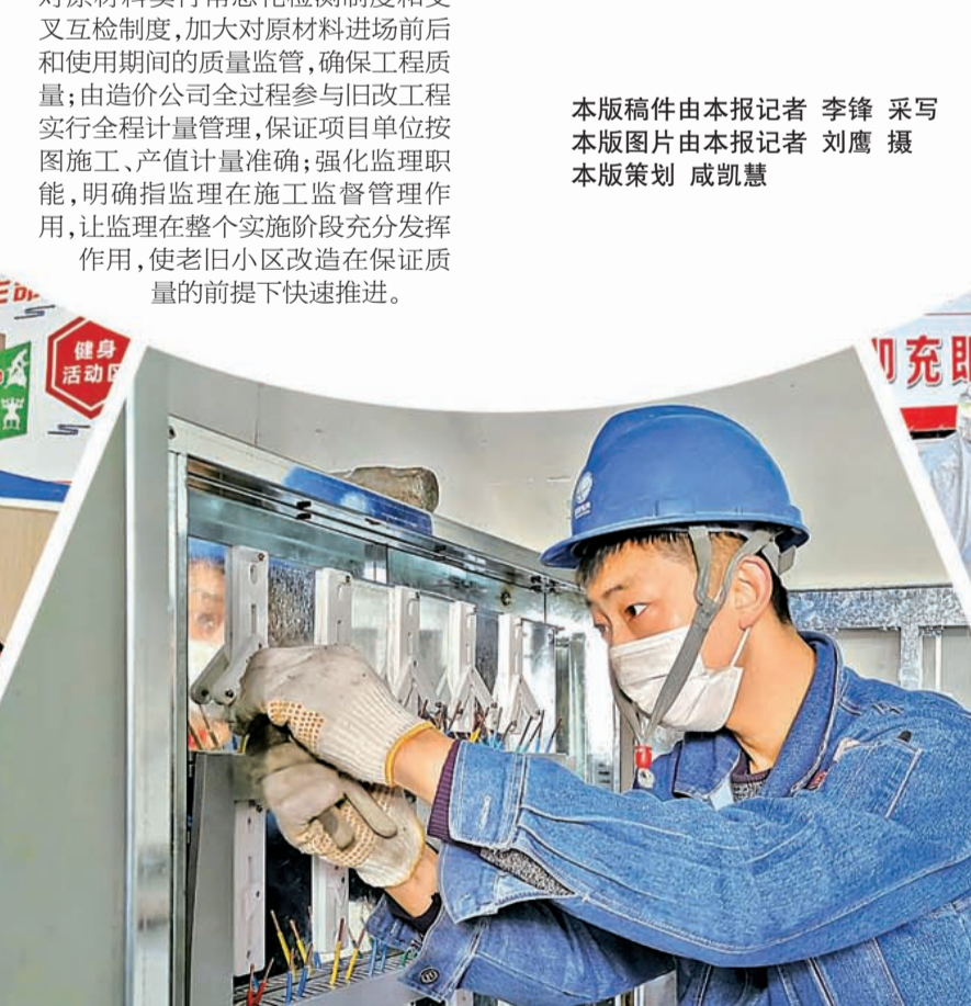
针对老旧小区电力设施老化、故障多、风险大等问题,电力部门进行电力设施改造,补齐了民生短板。
