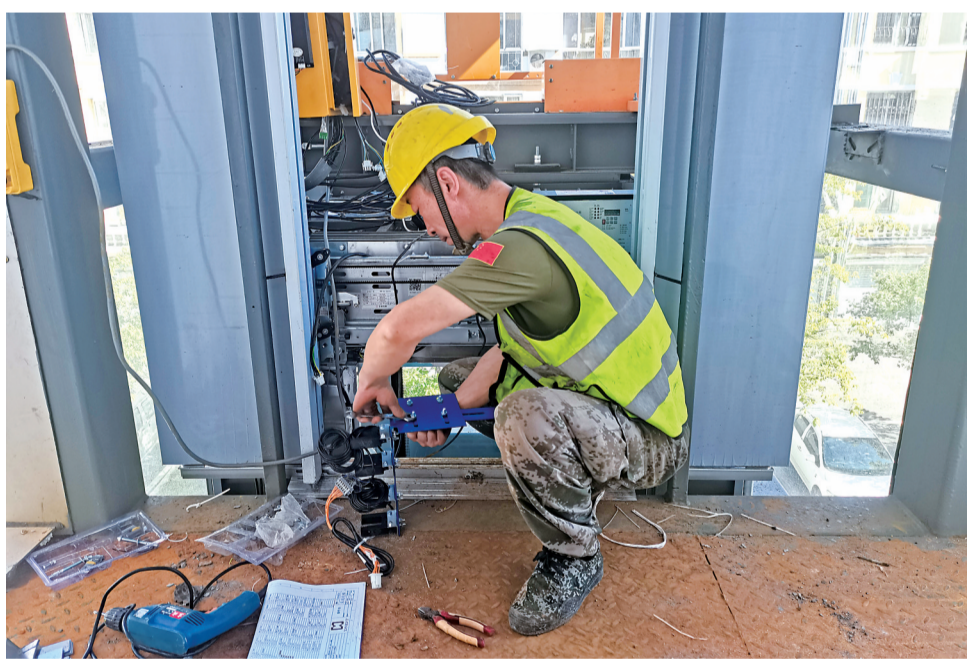
利源小区新加装电梯正在进行布线作业。
