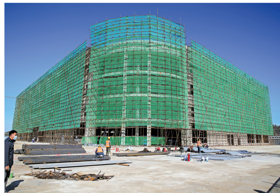
红星美凯龙全球家居博览中心项目施工主体建筑已落成。
