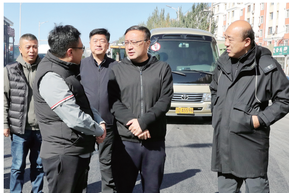
10月5日,市委副书记、市长程宇调研督导城建项目推进工作。图为程宇在西宁大路施工现场了解相关情况。本报记者 夏景明 摄
