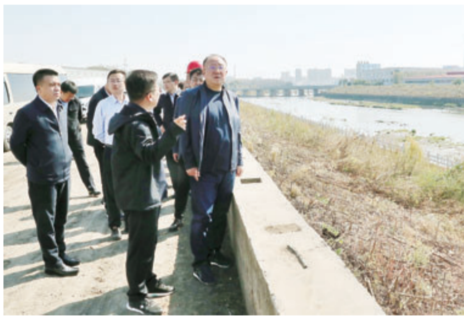
9月28日上午,市委书记柴伟调研督导环保督察任务整改情况。图为柴伟在石油公司储油库门前破损路段修复现场了解相关情况。 本报记者 夏景明 摄
