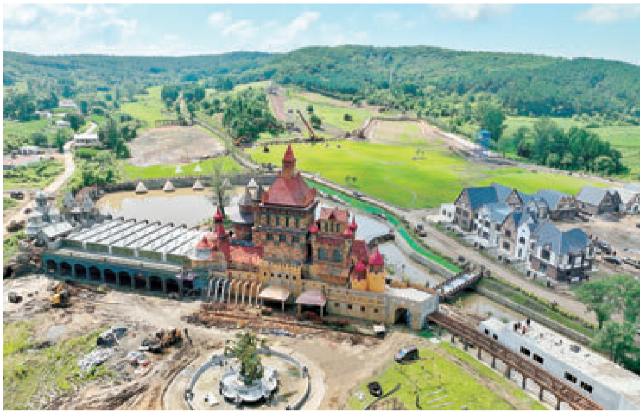
田雨·德国风情小镇项目正在如火如荼建设中。
