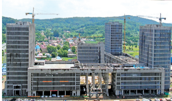
计划明年三四月份完工的“双创”产业中心项目,目前正在进行内部砌筑和水电、消防、通风等设施安装。
