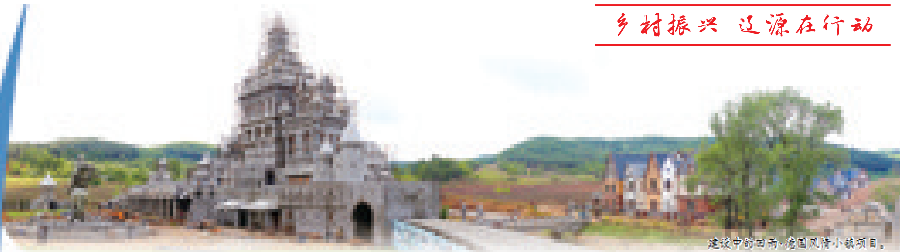
建设中的回廊·德国风情小镇项目。
