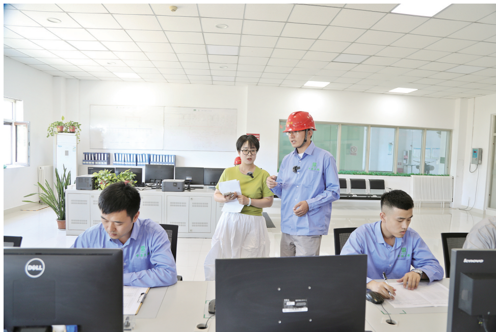
集控室内,工作人员对锅炉、汽机的实时参数进行调整分析。
