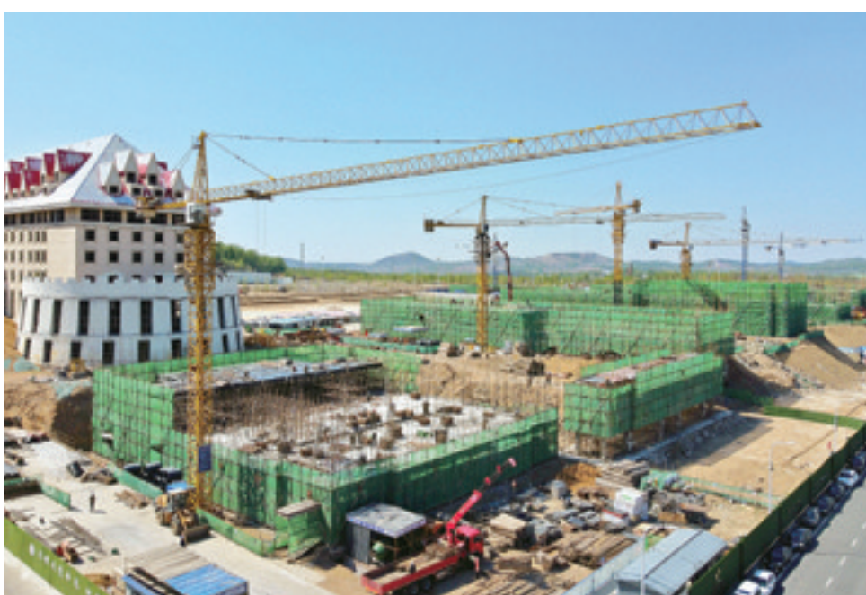
占地面积9.6万平方米,建筑面积5.6万平方米,总投资2.2亿元的辽源市启臻文化教育产业园项目正在紧张施工中。 本报记者 刘彦 摄
