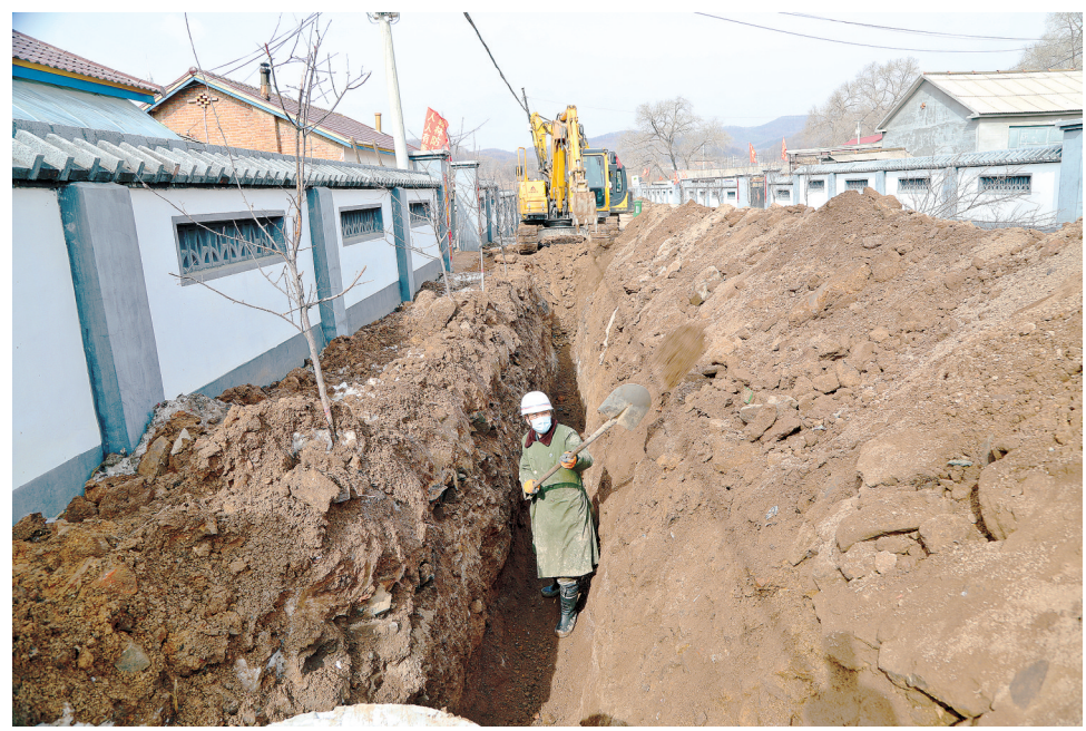
东辽县辽河源镇安北村污水管网铺设工作有序进行中。
