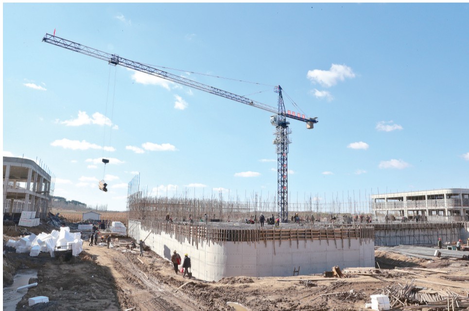
中国·吉浙东丰松籽产业园项目正在施工。
