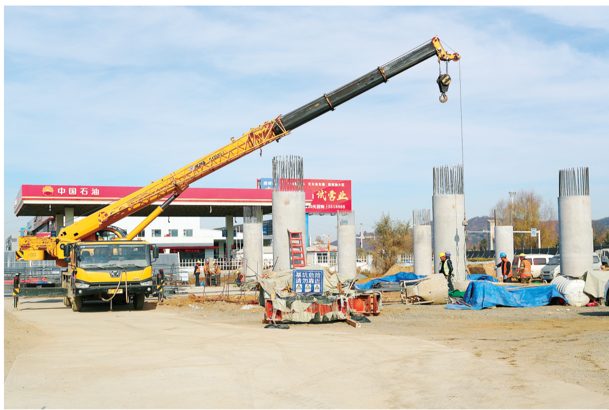
国道集阿公路(G303)辽源红五星互通立交改建项目施工现场一派繁忙景象。
