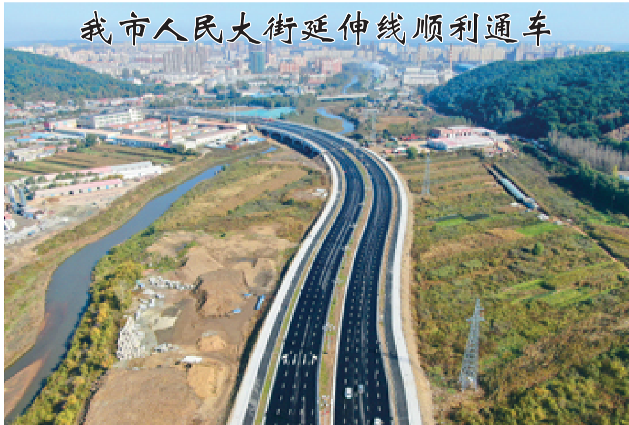
10月1日,我市南部新城人民大街延伸线道路工程竣工,实现全面通车。
