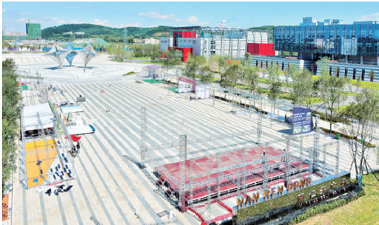
8月29日,南部新城南仁东广场上,房交会展台建设有序进行中。
