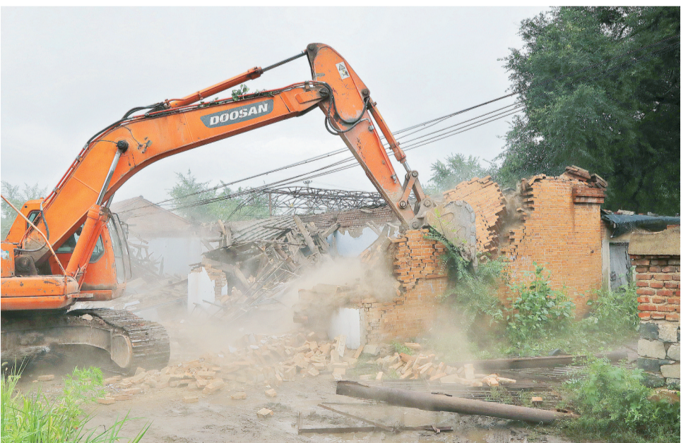
东山街道危楼拆除现场。
