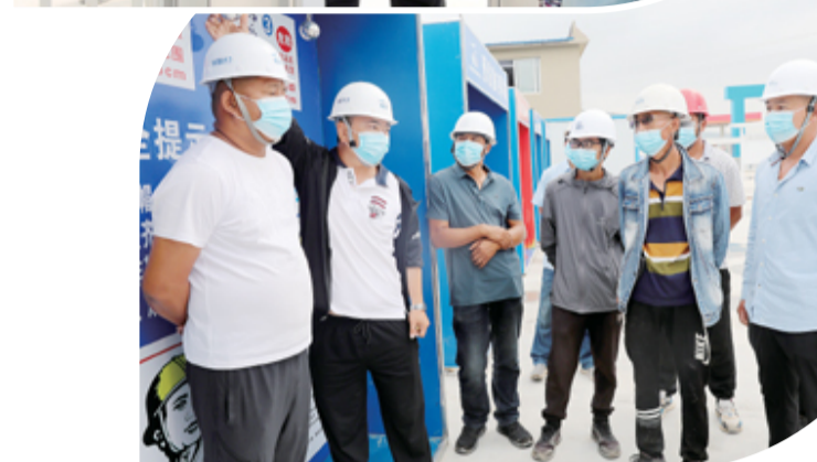
市中心医院异地建设项目现场,工人通过面部识别门禁入场(上图) 市中心医院异地建设项目工地内,施工方安全员向入场人员进行安全生产培训(下图)
