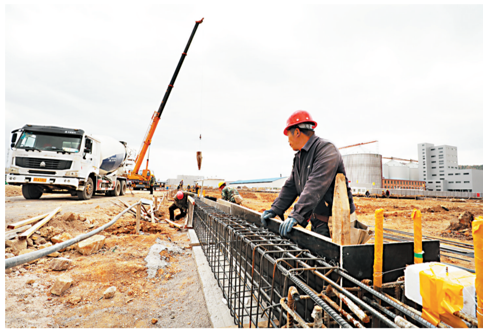
中国·蛋谷暨智能仓储冷链物流项目施工现场。
