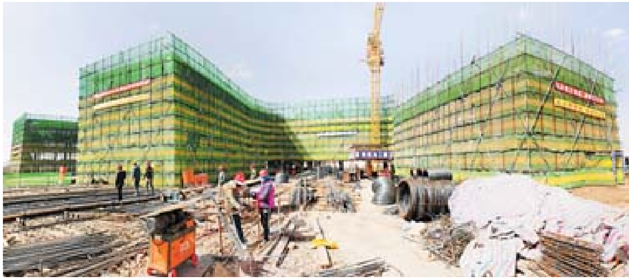
东丰县鹿乡中学项目建设施工现场。
