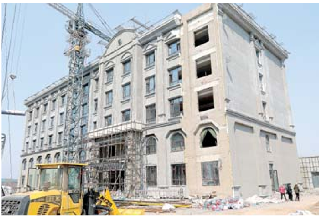
诺丁山文化创意产业园一期项目喜糖婚礼酒店的主体结构施工已全部完成。
