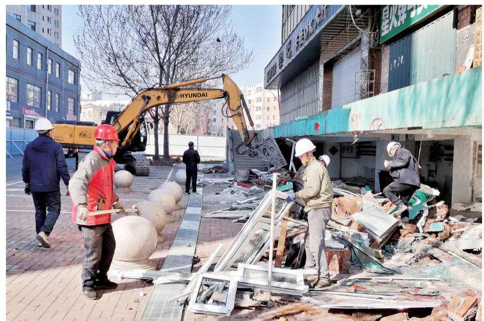
4月7日,仙人河第四段盖板楼一层平台下的违法建筑被相关部门依法集中拆除。
