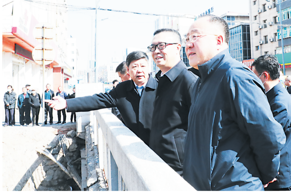
4月7日,副省长韩福春深入我市调研指导工作。图为韩福春(前排右二)在仙人河圣板桥拆除现场调研。本报记者 夏景明 摄
