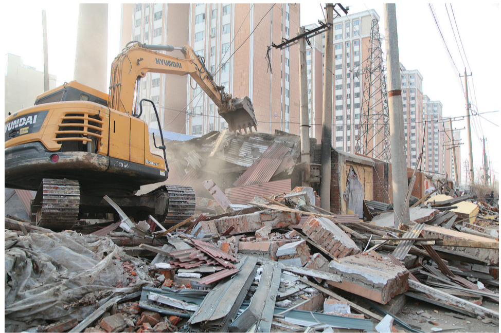
东山街一委(辽源市第二实验中学周边)的违法建筑被依法拆除。 本报记者 吴培民 摄
