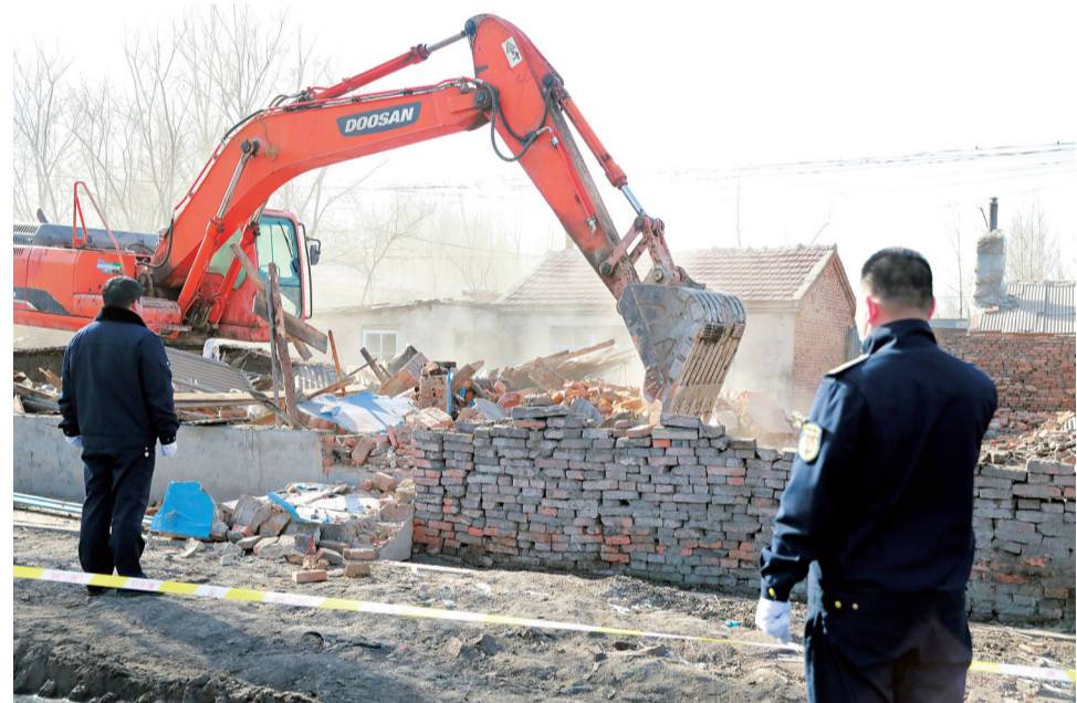
3月16日,西安大路两侧15处违法建筑物、构筑物被依法拆除。 本报记者 刘鹰 摄
