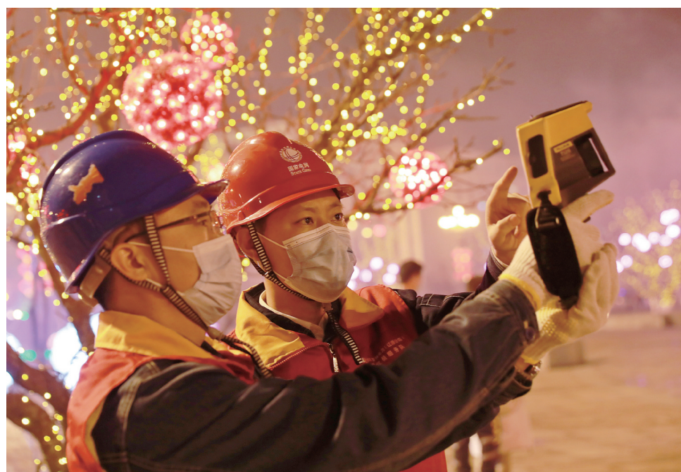
为确保春节期间电力供应,连日来,国网辽源供电公司坚持24小时值班制度,全天受理各类故障报修工作,做到客户故障报修快速反应、及时处理。图为2月11日晚,国网辽源供电公司党员服务队队员对辖区内线路进行测温监测工作,为客户用电安全提供保障。
