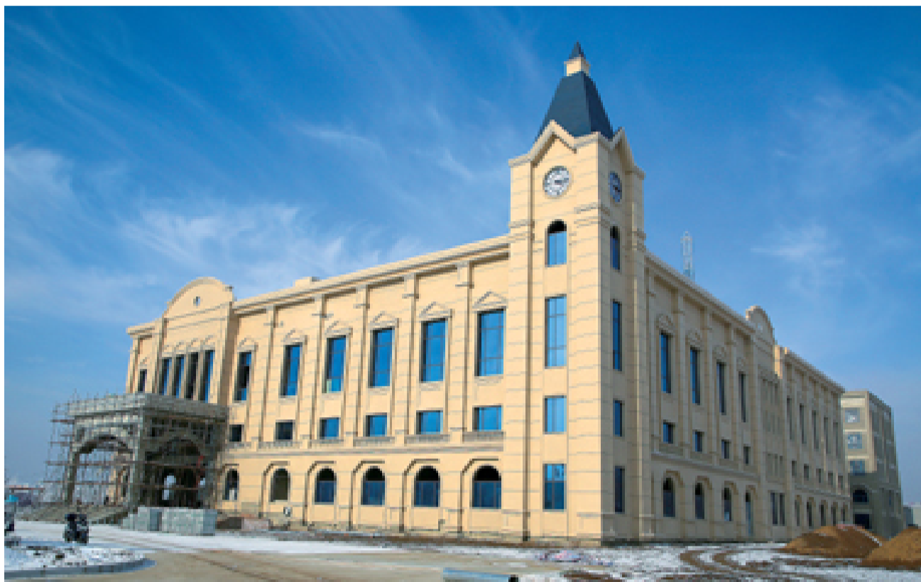
诺丁山文化创意产业园项目一期工程已封顶,正在进行内部装饰。
