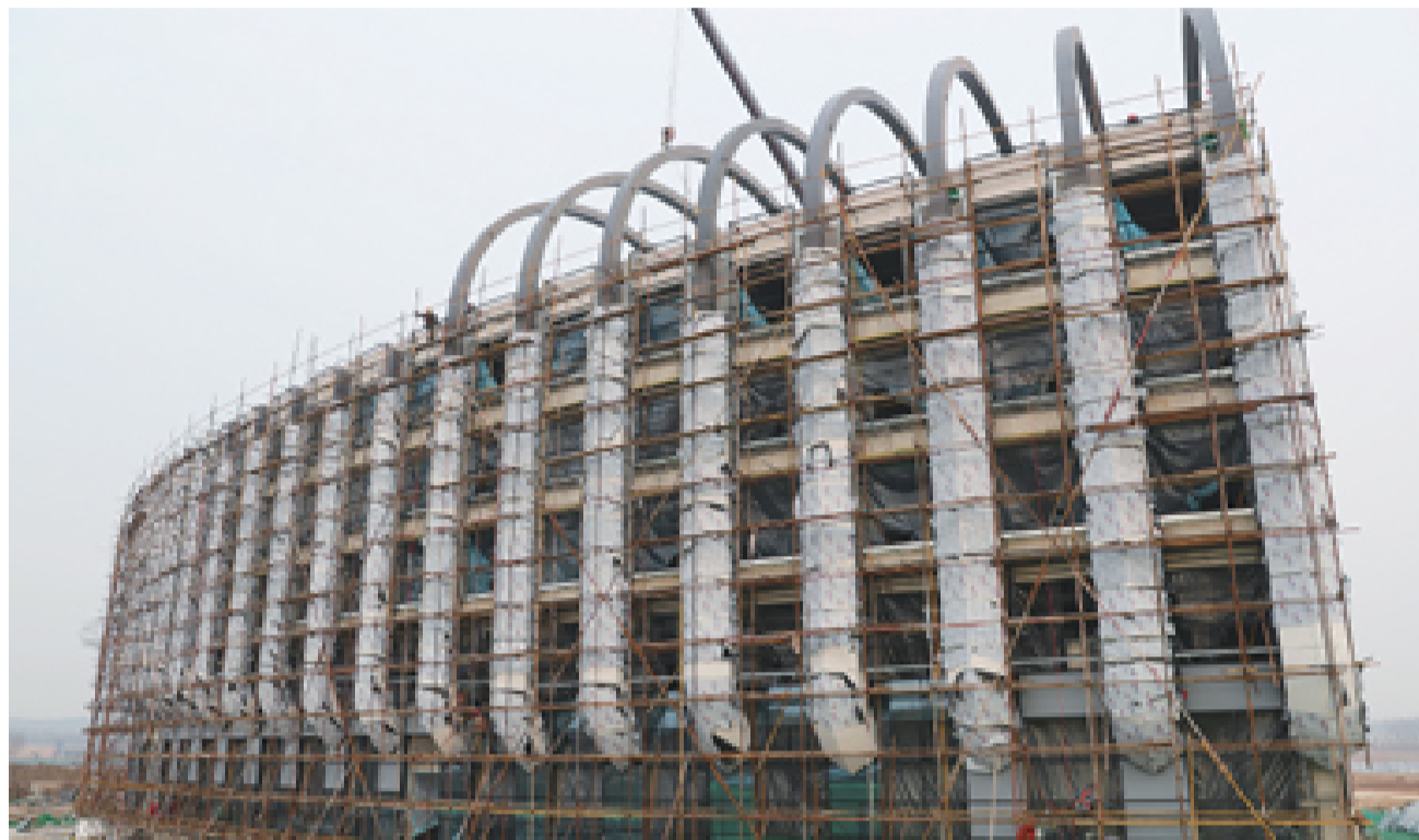
东丰国际梅花鹿产业创投园一期建设项目施工现场。
