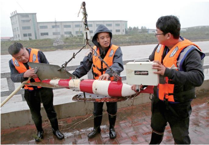
9月8日,受第十号台风“海神”影响,我市迎来大范围持续降水,东辽河水位明显上涨。辽源水文站工作人员冒雨作业,安装雷达波测流系统,对东辽河进行流量监测。本报记者 魏利军 摄
