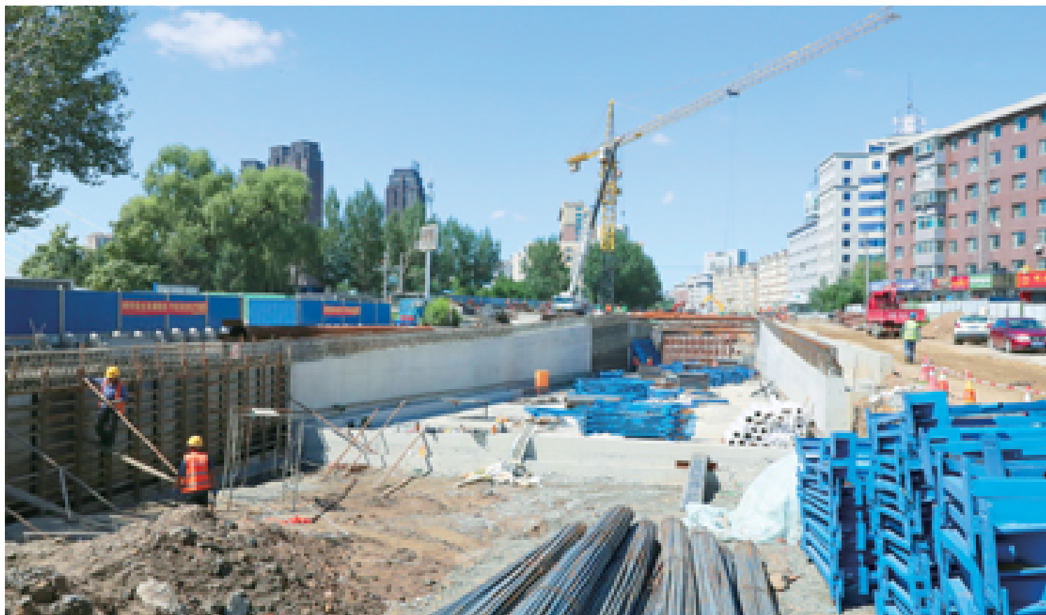
辽源大路下穿工程隧道总长三百米,敞开区U型槽长度一百四十五米,敞开区段土墙八十米,封闭段长度七十五米,隧道净宽十五米,设置双向四车道。封闭段采用单洞单孔箱型截面。目前,隧道主体结构混凝土浇筑等工作正在有序进行中。本报记者 夏景明 摄
